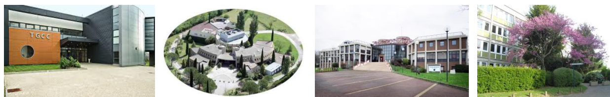
Figure 35. Les 4 data centers nationaux: TGCC à Bruyères-le- Châtel, le CINES à Montpellier, CC- IN2P3 à Villeurbanne, IDRIS à Orsay =© Ministère de l'Enseignement supérieur et de la Recherche.
