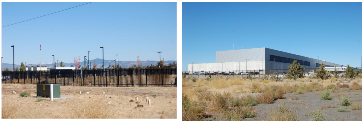
Figure 20. Data center d'Apple et Facebook, Prineville Crédits=© Cécile Diguët et Fanny Lopez, 2018.
